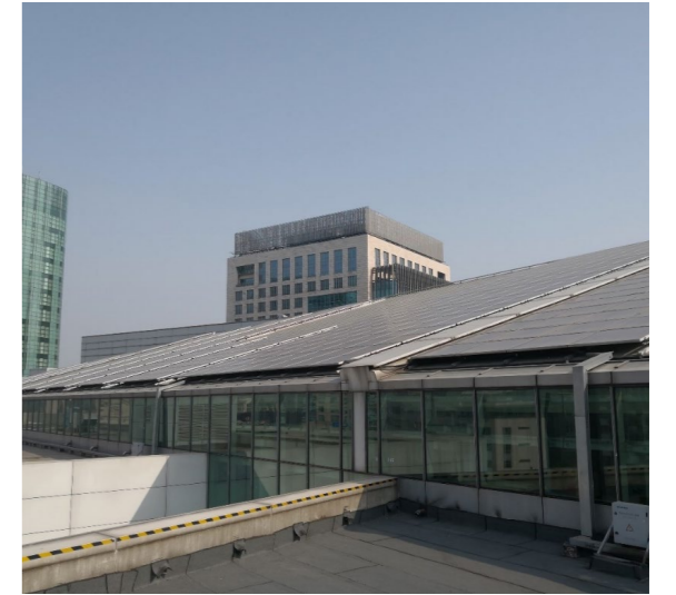
金融街购物中心建筑顶部铺设光伏面板
