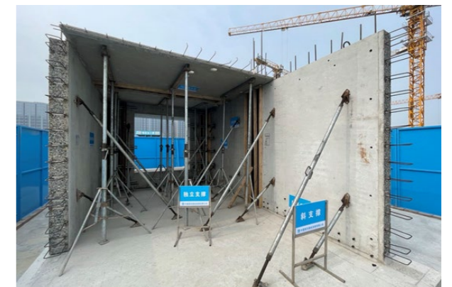
亦庄金悦郡项目—现场照片
