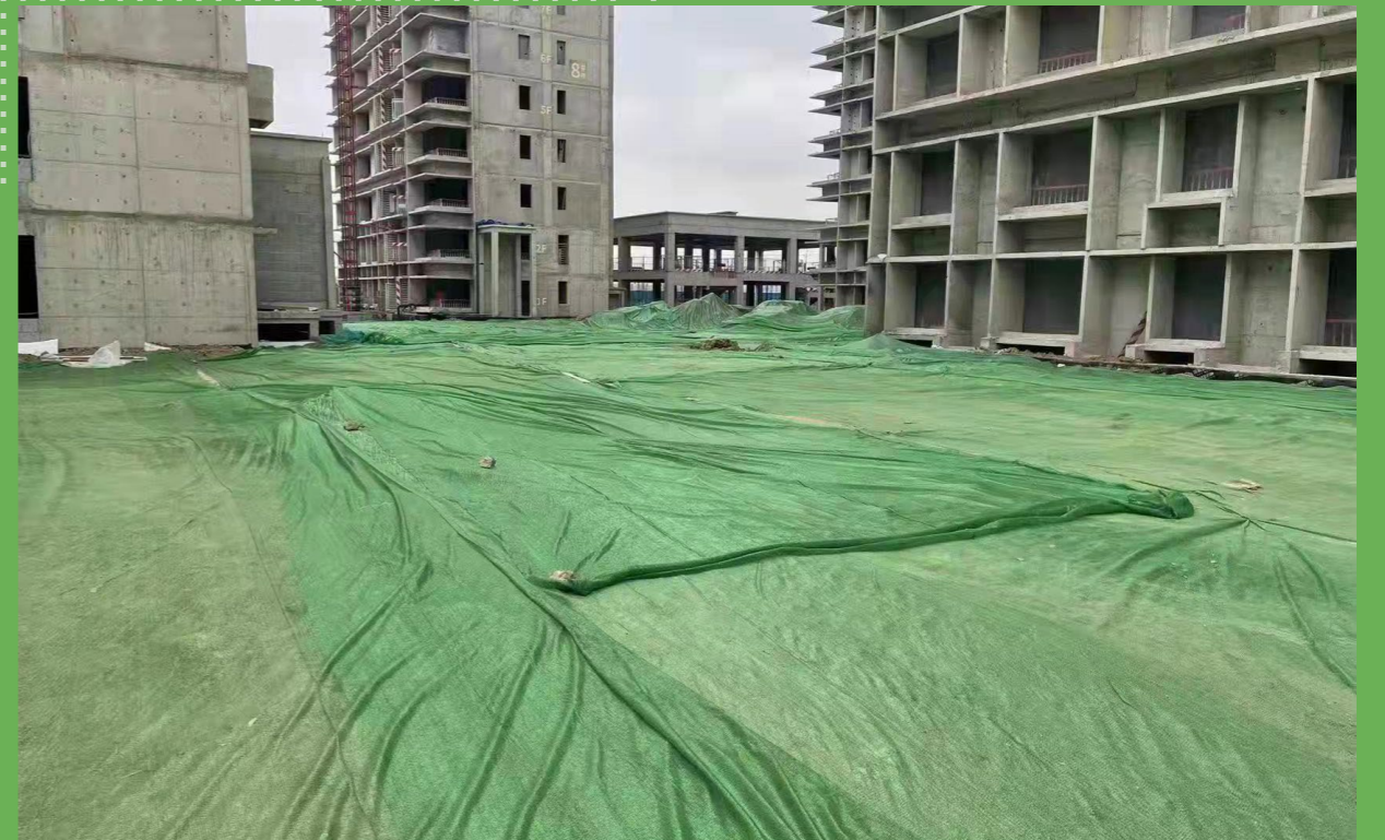
防范黄土露天措施
