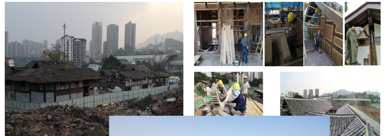
▲ 旧城古迹原貌（修复前）
