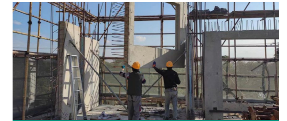
上海宝山美兰金悦府项目装配式建筑施工现场
