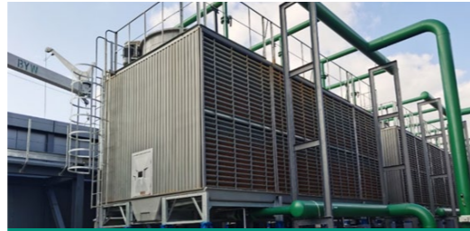
项目获奖单项-机电工程通暖照片
